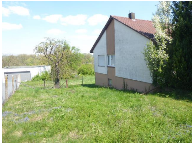
Abb. 7: Westseite des Wohnhaus (Flst.-Nr. 166/1) mit angrenzender Bebauung.
