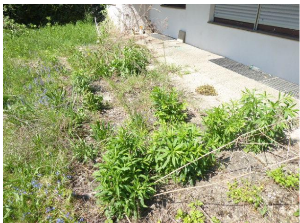
Abb. 11: Terrasse an der Südseite des Wohnhauses mit fortschreitendem Bewuchs.
