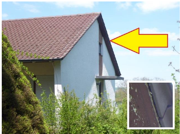
Abb. 9: Ostseite des Wohnhauses mit Spalten zwischen Hauswand und Ortsgangziegeln.
